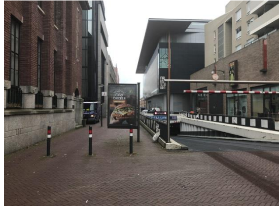
Figuur 9 Parkeergarage zaailand
